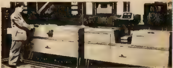
Masă specială de manipulare a substanțelor radioactive, care protejează pe cercetători (laboranți) de radiații.
